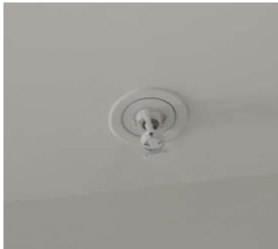
Figura 43 Sistema contra incendios, rociadores (NFPA 13).
