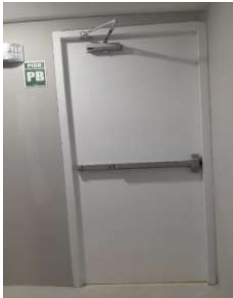
Figura 41 Puerta corta fuego. Norma (ART. 12.7.4.2 – NFPA 10).
