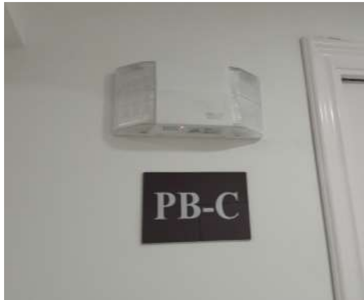
Figura 52 Lámparas de emergencias, norma (ART. 7.9 – NFPA 101).
