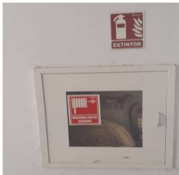
Figura 38 Manguera contra incendios, norma (NFPA-14).
