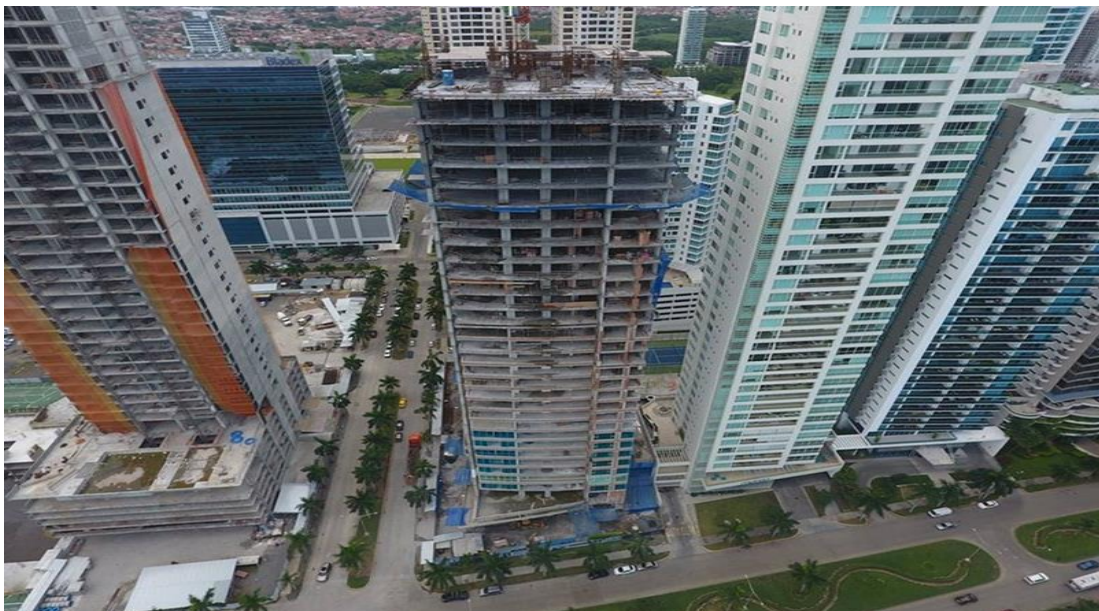
Imagen N° 1. Edificio en construcción.
