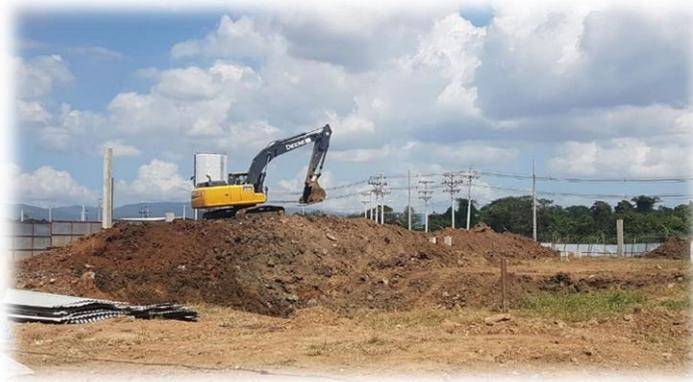
Máquina autopropulsada sobre orugas con una superestructura capaz de girar 360° con un equipamiento montado, diseñada principalmente para excavar con un balde y manipulación de carga, sin que la estructura portante se desplace durante el ciclo de trabajo.
