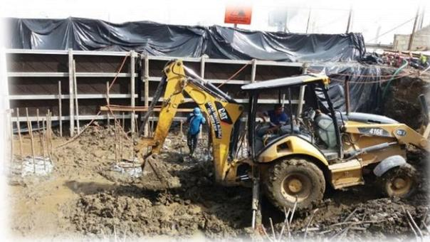
La retroexcavadora es una máquina que puede hacer el trabajo de un cargador frontal, una topadora y una excavadora.
